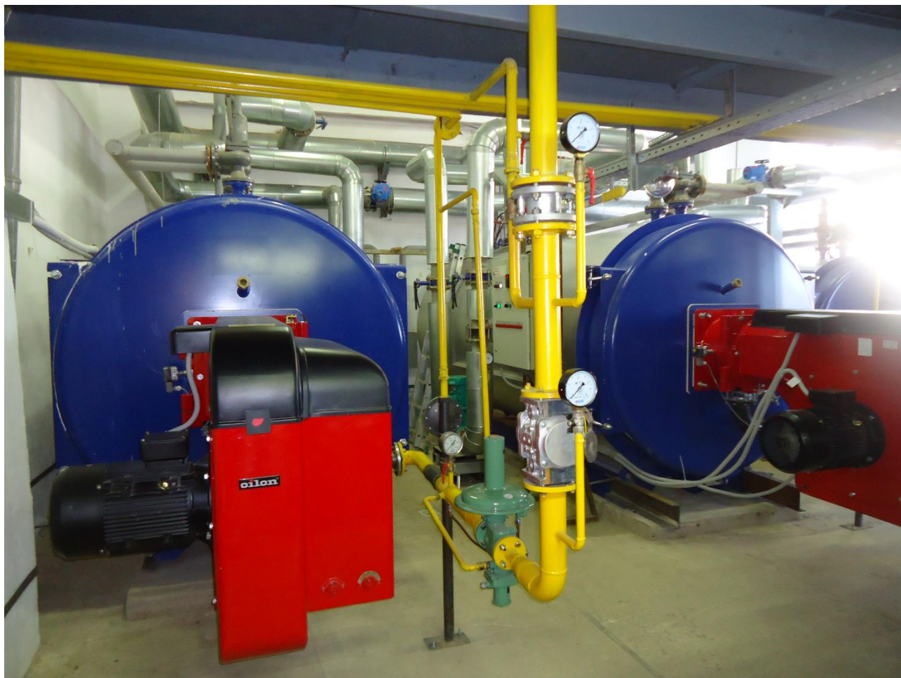
Рисунок 1.2.17 Установка автоматизированных котлов в котельной №13
